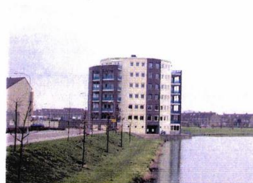
17 naam :Het Rondeel datering :1999 functie :woontoren hoogte :20 m.
